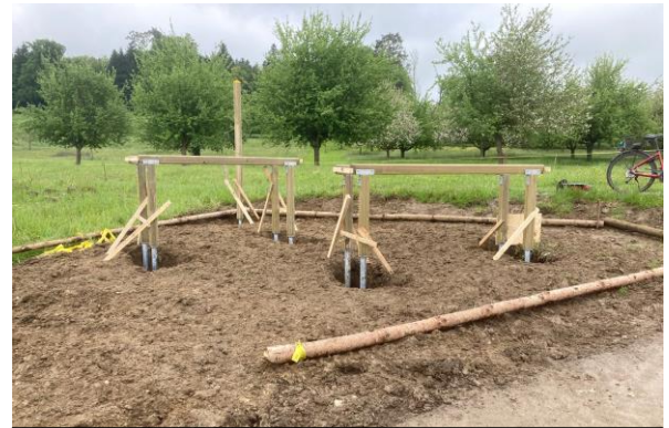
Posten 7 (Barrenturnen) bereit zum Einbetonieren
